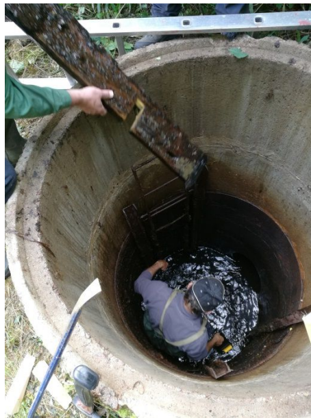
Gamla plankor tas bort.
