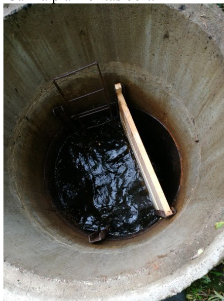
Nya plankor - färdigt
